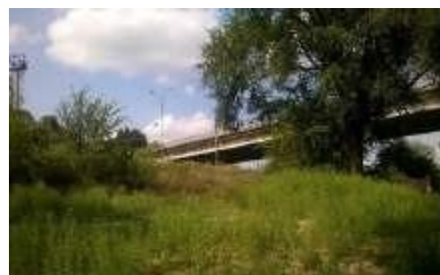
Figura 23. Căile de acces neamenajate și nesigure în zona Ungheni Vale
