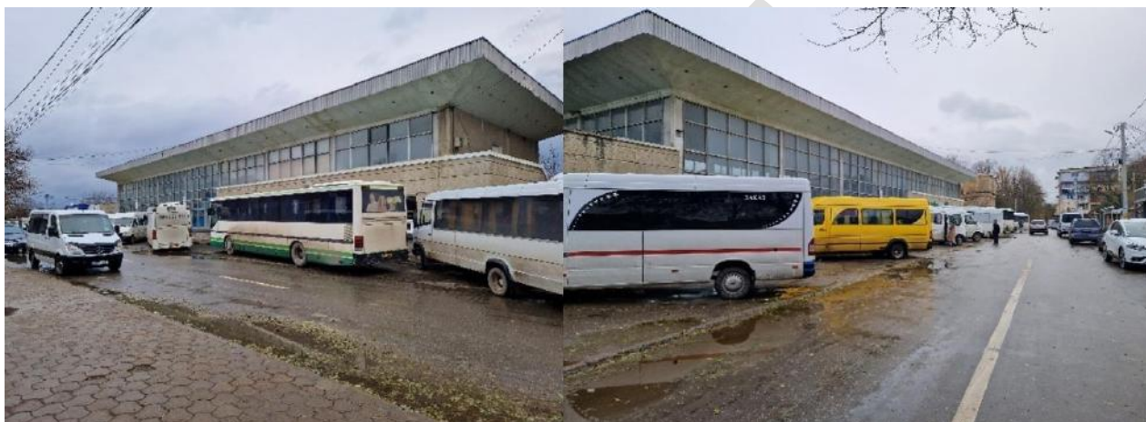
FIGURA 71. AUTOGARA UNGHENI – VEDERE DINSPRE ZONA CENTRALĂ
