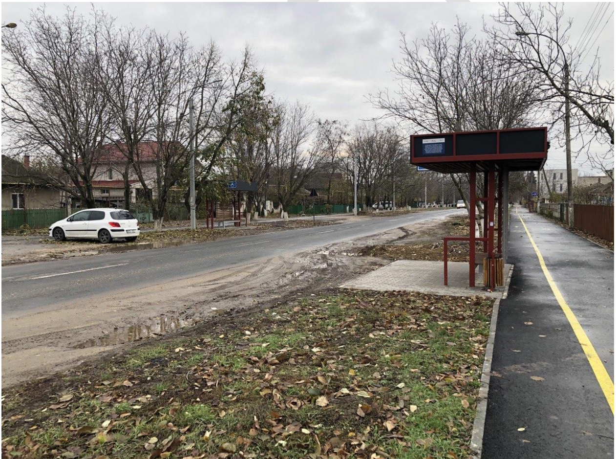
FIGURA 39. STAȚIE DE TRANSPORT PUBLIC FĂRĂ TRECERI PIETONALE ȘI PLATFORMĂ PENTRU ÎMBARCARE ȘI DEBARCARE DIN MIJLOACELE DE TRANSPORT
