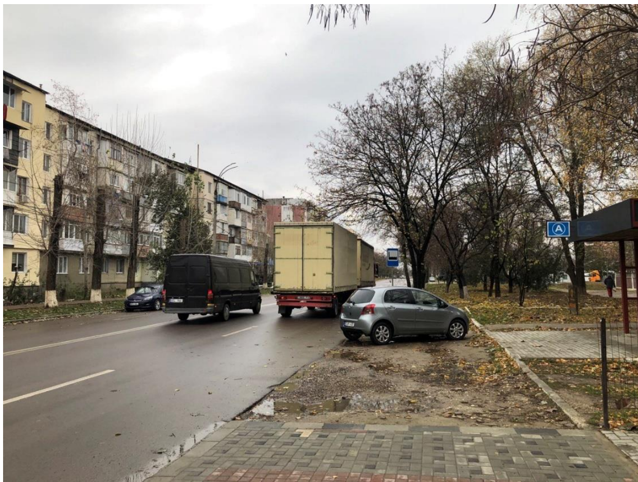
FIGURA 47. TRANSPORT DE MARFĂ PE STRADA ION CREANGĂ
