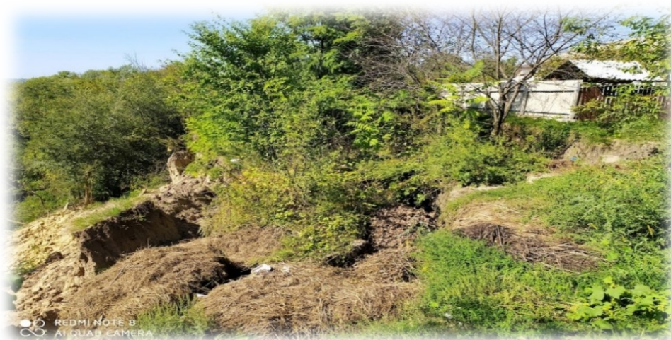
Figura 3. Alunecări de teren în zona str. A. David din municipiul Ungheni în preajma colectorului principal
