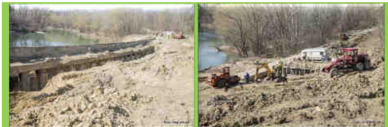
Lucrări de consolidare a malurilor râului Prut
